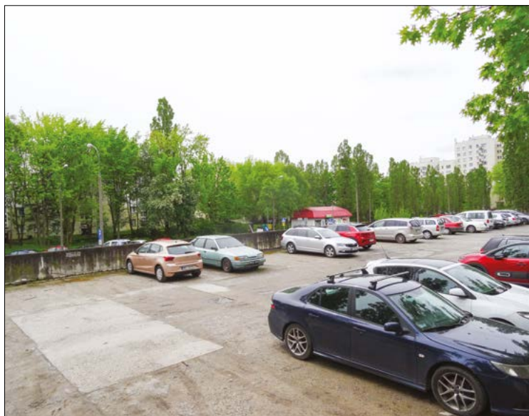
Parking nad garażem ul. B. Bartoka. Fot. Andrzej Rogiński
